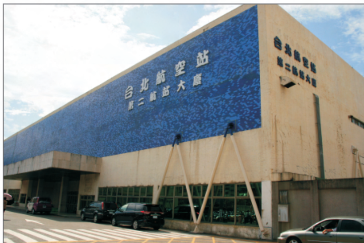
松山機場第二航廈耐震補強工程
