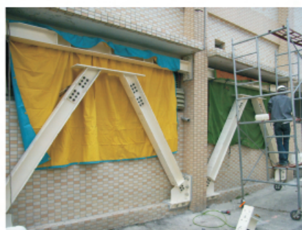
化學錨栓固定
