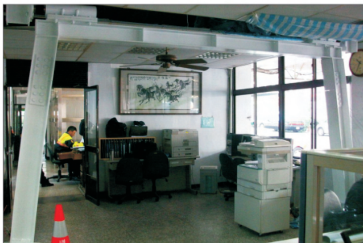
國道警察苗栗段造橋分局耐震補強工程
