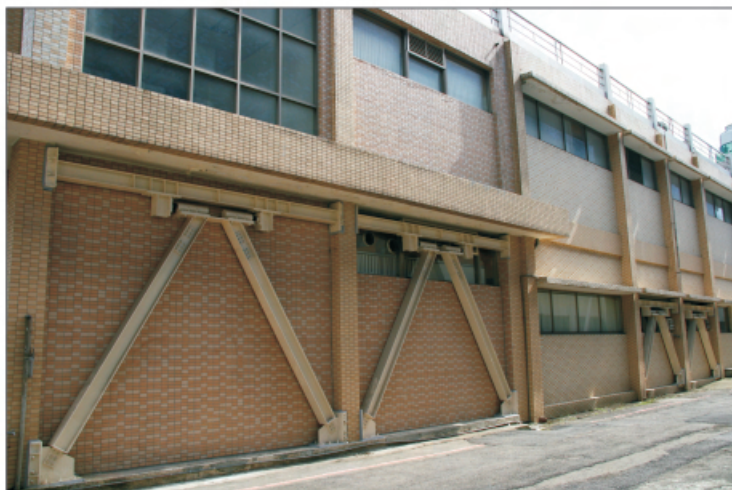
松山機場第二航廈耐震補強工程
